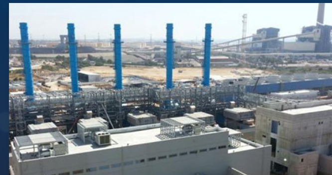
Dorad 840MW Power St. Ashkelon
